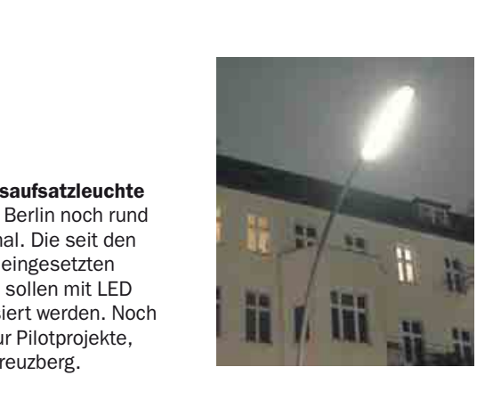
Der Peitschenmast (1955) ist für Gasleuchten entwickelt worden, sagt Licht-Expertin Sabine Röck. Aber heute hängen vor allem Elektroleuchten daran, viele mit Quecksilberdampflampen, die bald verboten werden.
